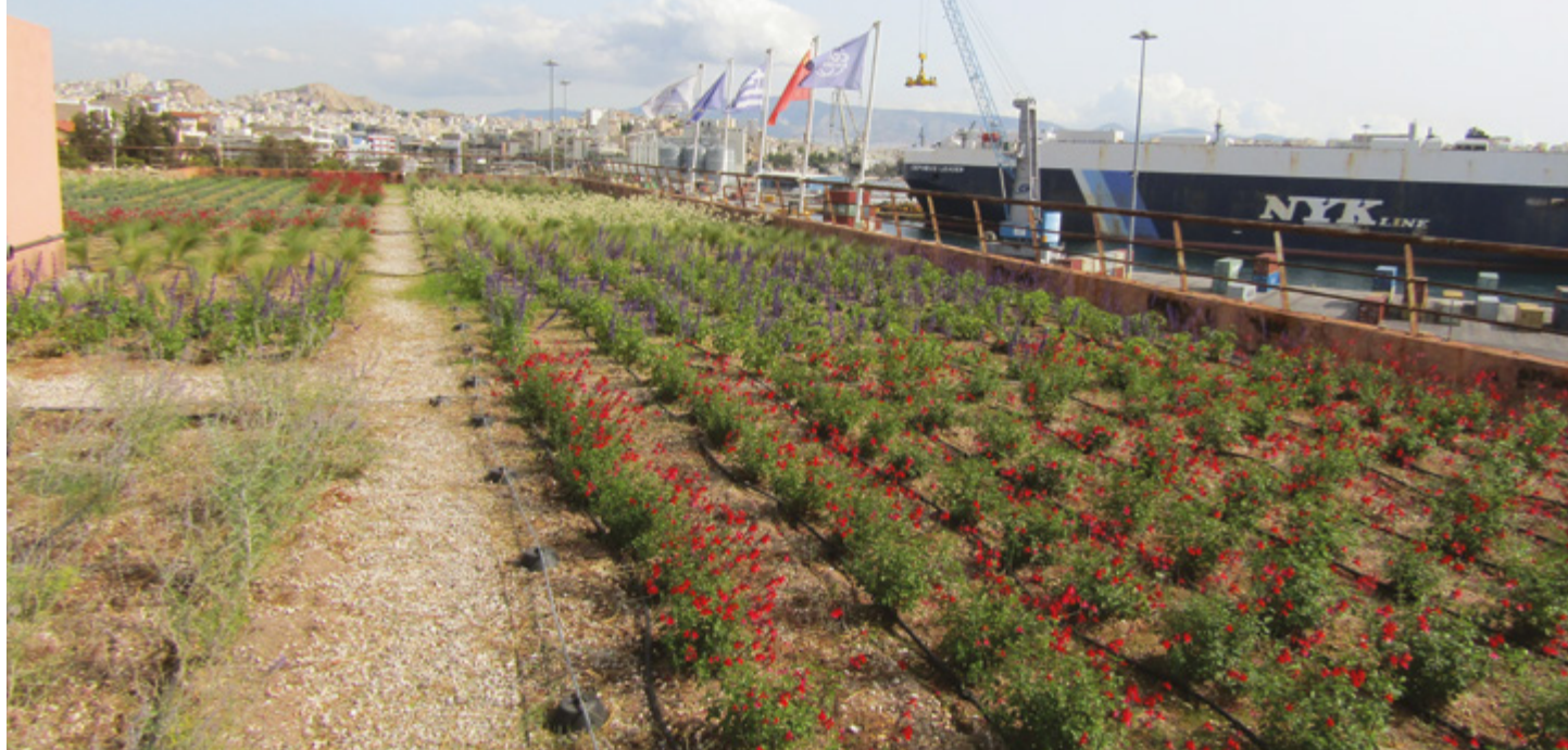
Φυτεμένο δώμα στην οροφή του κτιρίου του Σταθμού Εμπορευματοκιβωτίων
