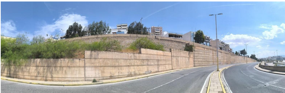
Φωτογραφίες 2 & 3: Τοιχείο σκυροδέματος, το οποίο σήμερα αντιστηρίζει τις γαίες (εκτιμώμενου ύψους ελάχιστο/μέγιστο 1,50μ με και 3,00μ) και τοιχείο από λιθοδομή ύψους περί τα 2,00μ με 2,50μ.
