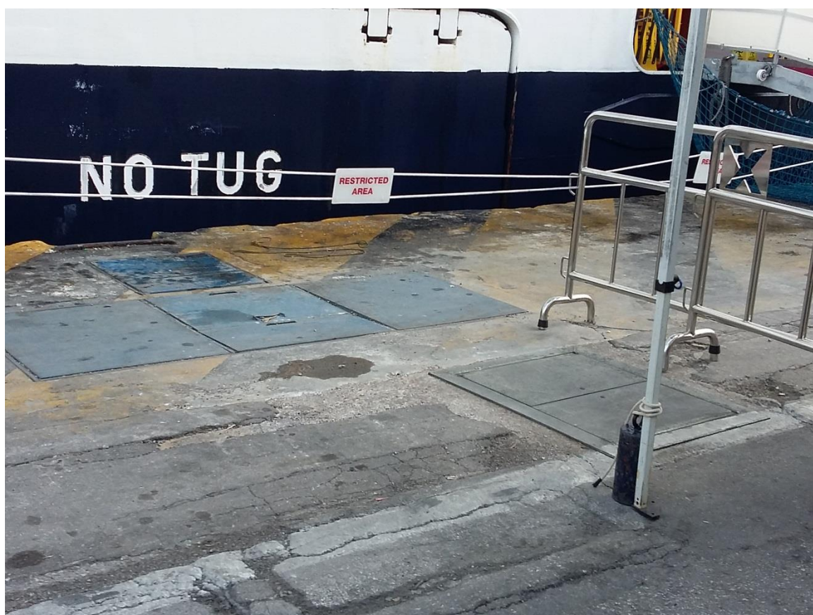
Φώτο 7 - Φρεάτια του δικτύου απορροής λυμάτων πλοίων
